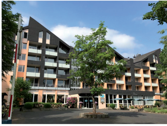
Das „Basislager“: Hotelpark „Der Westerwald Treff“
